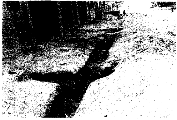
vista instalacion de redes de agua
